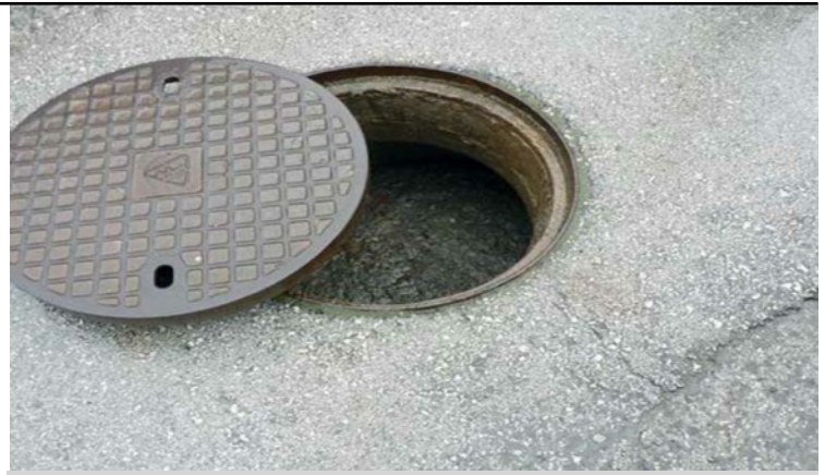
Je vyhodnocováno měření průtoku odpadních vod v kanalizaci
