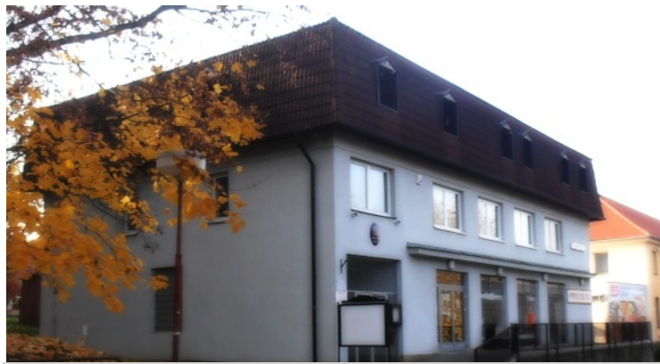
Zateplení budovy OÚ by znamenalo úsporu finančních prostředků za provoz budovy
