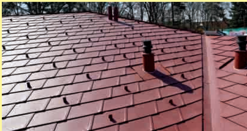
Zbrusu nová střecha
