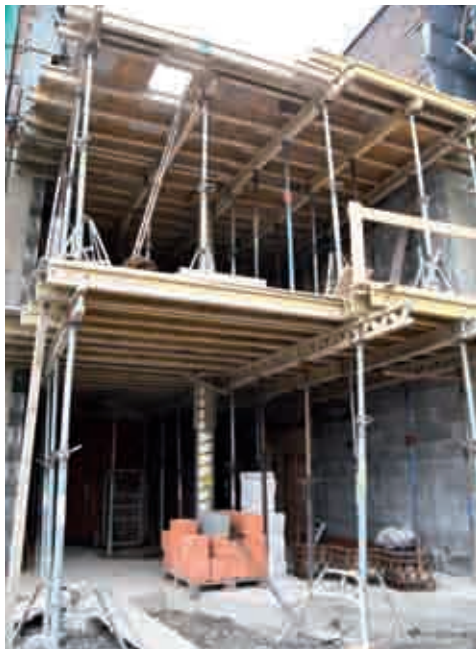
Přístavba nových jídelen
