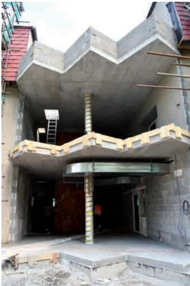
Přístavba nových jídelen
