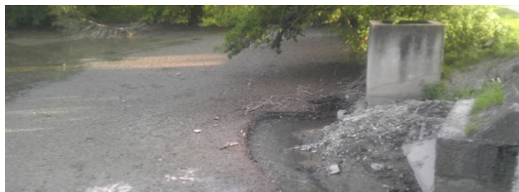
Rybník je vypuštěn kvůli plánovanému odbahnění
