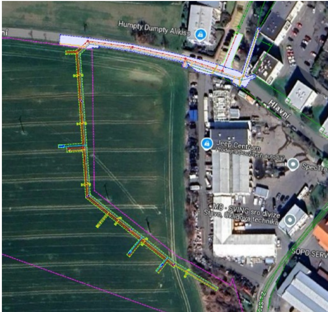
Obrázek 1: Stavba rozšíření vodovodů a kanalizací právě probíhá
